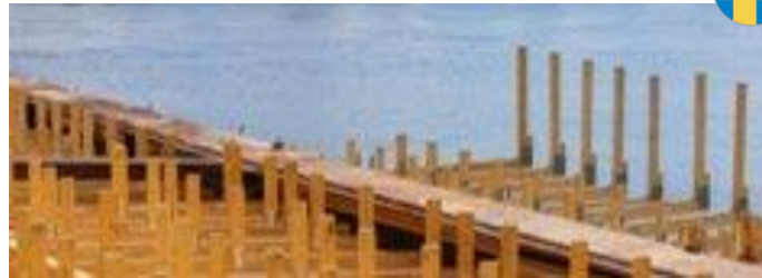
Bridge project, Leipikälven
